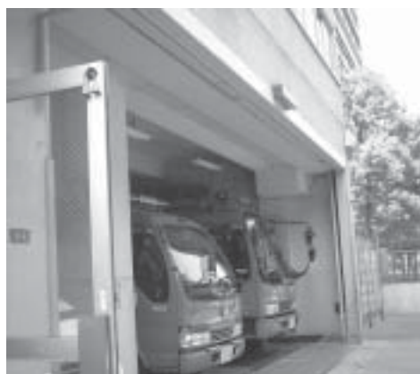
例えば渋谷消防署代々木出張所シャッター幅10メートル。右写真参照) IS値が1階部分はなんと0.22。
